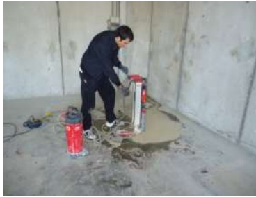
Figg. 12 - 13: Esecuzione di un carotaggio; misura dello spessore sulla carota estratta
